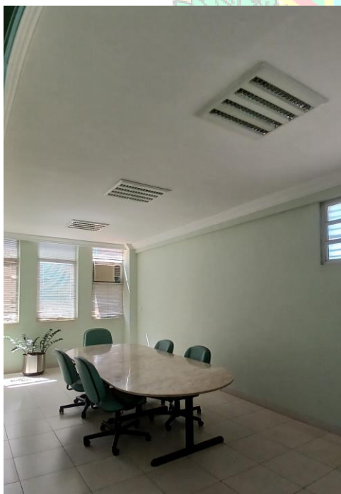
Figura 5 - Sala de Reunião (Local onde serão desinstaladas as lâmpadas fluorescentes T5/reatores e instaladas as lâmpadas LED TUBE 8W T5 BIVOLT 6500K)
