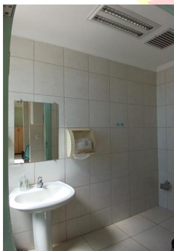
Figura 9 – Banheiro Copa (Local onde serão desinstaladas as lâmpadas fluorescentes T5/reatores e instaladas as lâmpadas LED TUBE 8W T5 BIVOLT 6500K)
